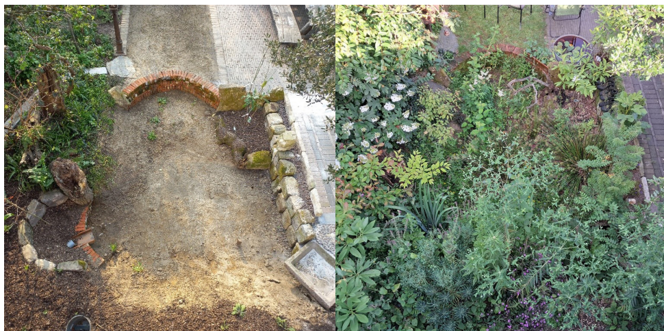
Aanleg wadi - Foto Tim
